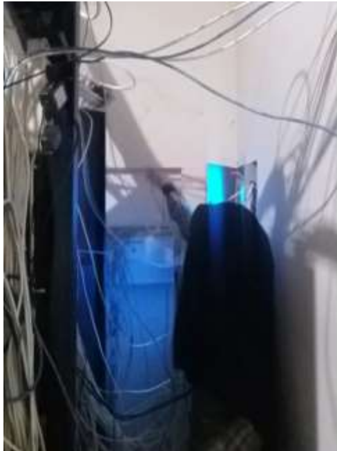
Penyambungan Kabel Menuju Server
