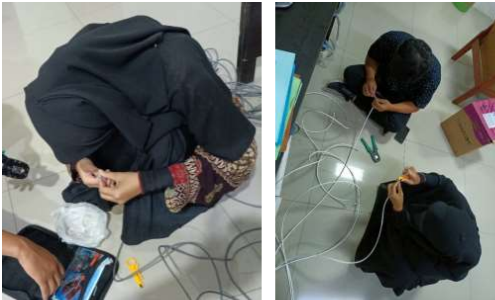
Gambar 6. Instalasi Kabel pada Bidang
