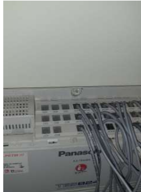
Penyambungan Kabel Menuju Terminal PABX
