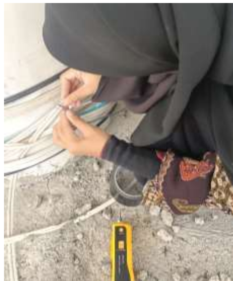
Gambar 3. Penyambungan kabel
