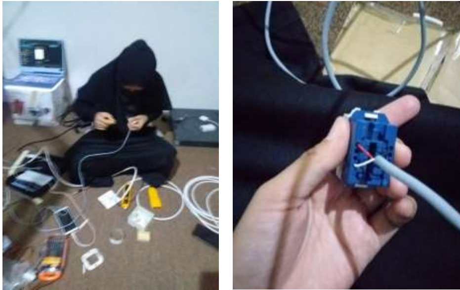
Gambar 4. Uji coba instalasi kabel
