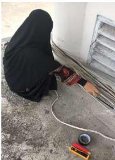
Gambar 3. Penyambungan kabel
