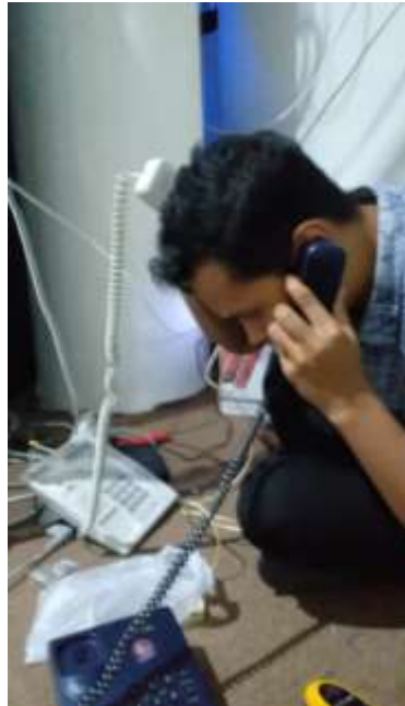
Gambar 8. Uji coba hasil instalasi
