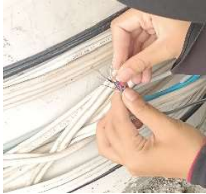
Gambar 2. Proses Penyambungan Kabel
