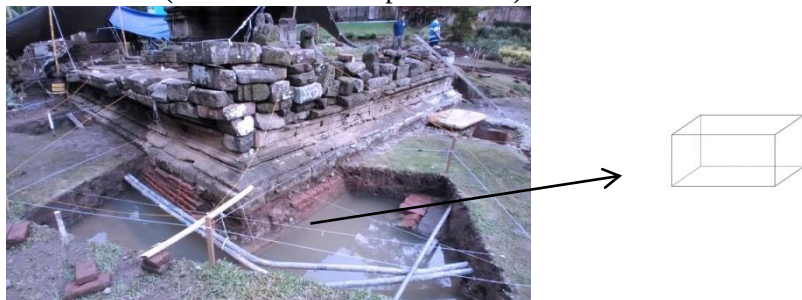
Gambar 3. Konsep Bangun Ruang Balok pada Pondasi Dasar Candi Songgoriti (Sumber : timesindonesia.co.id)
